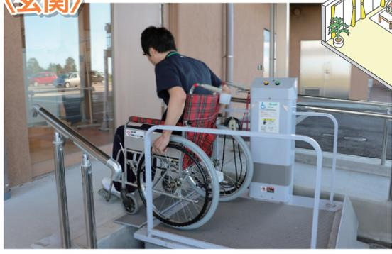
屋外用の昇降機。ボタン1つでリフトが上下して、段差を解消してくれます。患者さんの気軽な外出を手助けします。限られたスペースにも設置でき、介護保険でレンタルできるものもあります。
